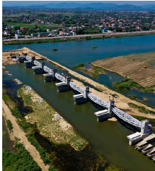
ĐẬP DÂNG HẠ LƯU SÔNG TRÀ KHÚC 特库河下游的大坝
