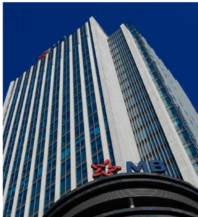
TÒA NHÀ NGÂN HÀNG MB BANK MB银行大楼
