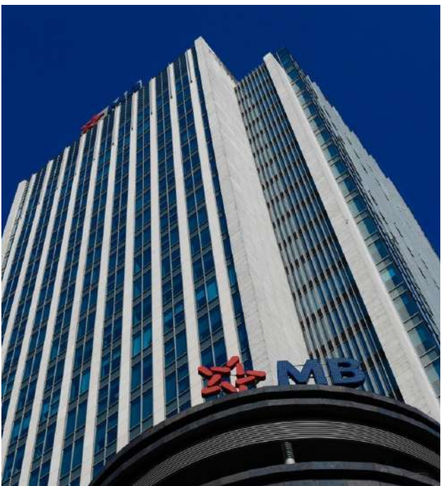
TÒA NHÀ NGÂN HÀNG MB BANK MB BANK BUILDING
